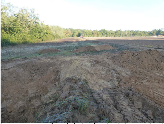
La terre excavée a été placée plus loin avec la chargeuse pour former des buttes.
