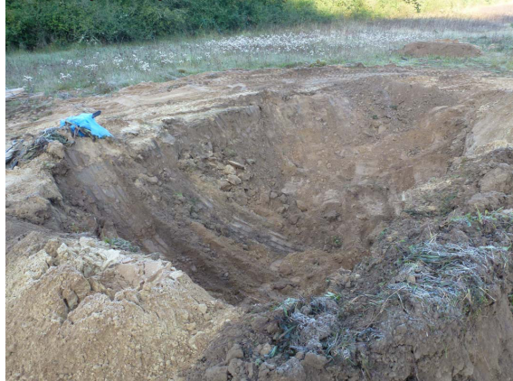
2e bassin réservoir, environ 12 m 3
